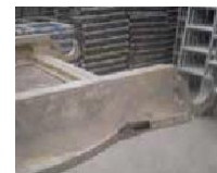
Zanieczyszczona powierzchnia powierzchni czołowej podestu
